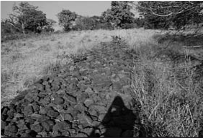
▲ Transport de pierres, digue filtrante en petit enrochement.
